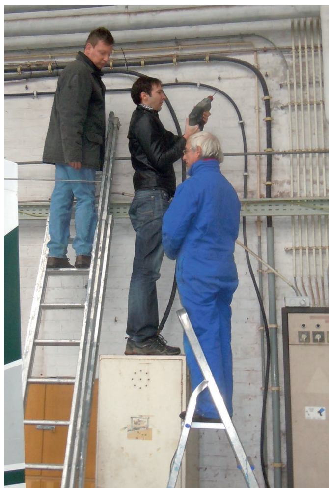
Electriciteitswerken in hangar Zuid door Walter, Mattijs en Luc
